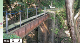
8 鬼ヶ沢橋梁 明治30年、下仁田から生糸、石灰石、鉄鉱石などを高崎へ運搬する為の上野鉄道が開通した際の鉄橋です。現在は使用されていません。傍らの地層には中央構造線の活動によって、切れ目に沿って固まっためずらしい石が見られます。
