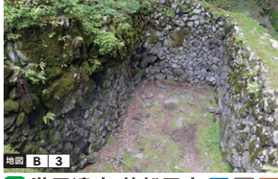
3 世界遺産 荒船風穴 明治38年から始まった養蚕保管のための天然の風を利用した冷蔵施設で、今も変わらず冷風を吹き出しています。冬季閉鎖：12/1～3/31 料金：500円
